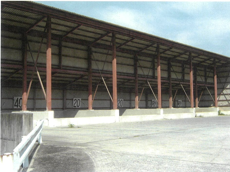
上屋付き骨材置場
