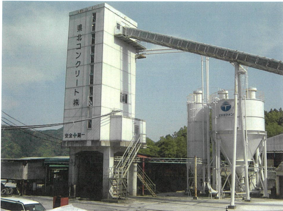
バッチャープラント
